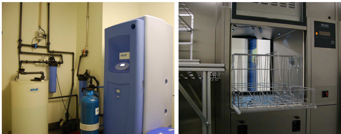
Figura 41 - Depósito de água, máquina de Osmose e máquina de lavagem e desinfeção
