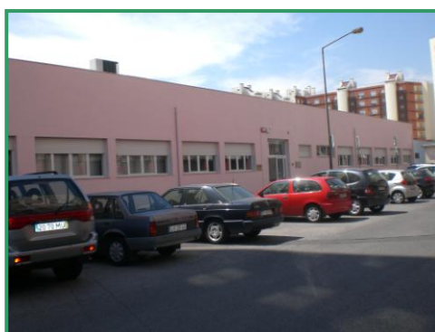
Fig. 2 – Fachada do Edifício da Unidade de Saúde Familiar de S. João Evangelista dos Lóios
